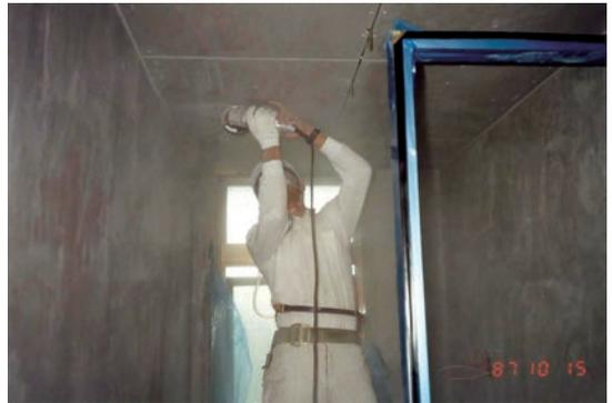
図1 天井の石綿セメント板をディスクグラインダーで切断。作業者の呼吸域の空气中石綿粉じん濃度は125本/cm<sup>3</sup>で、現在の石綿の管理濃度0.15本/cm<sup>3</sup>の833倍の高濃度であった。
